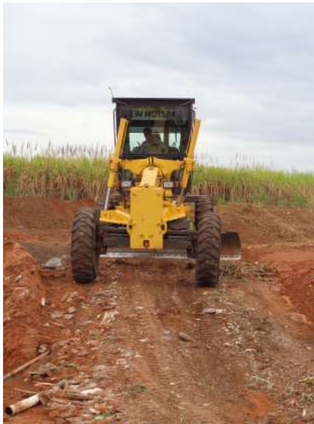
Figura 20. Reutilização dos RCC
