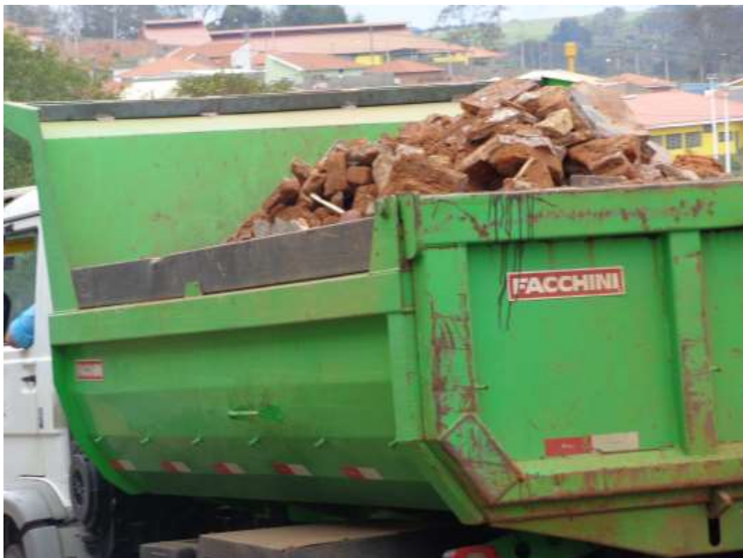
Figura 19. Transporte dos RCC
